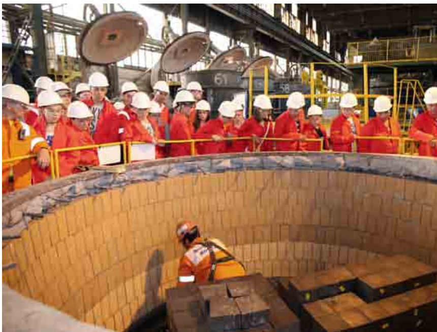
V panvovej hale návštevníci videli opravu žiaruvzdorných výmuroviek paniev a miešačov, v ktorých sa preváža tekuté železo a ocel.
